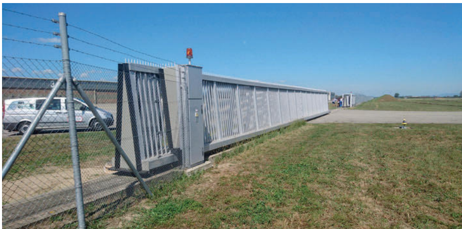
■ Es waren bei der Installation der Tore komplexe Ansteuerungssituationen zu realisieren.
