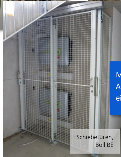
Trennwand Armasuisse, Bern BE
