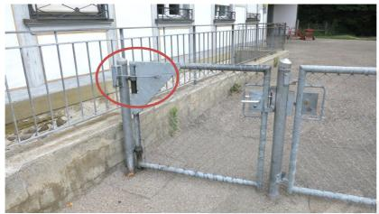
Der Türschletzer ist vereinfacht gesagt eine Feder, welcher die Türe schliesst. Die Feder ist in einer Bauform, welche eine drehende Bewegung ausführt.
