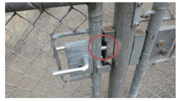
bedienen können. Wenn nun aber die Türe einfach aufgestossen werden kann, ist kein Schutz mehr da und aus der Distanz sieht die Türe meistens geschlossen aus.
